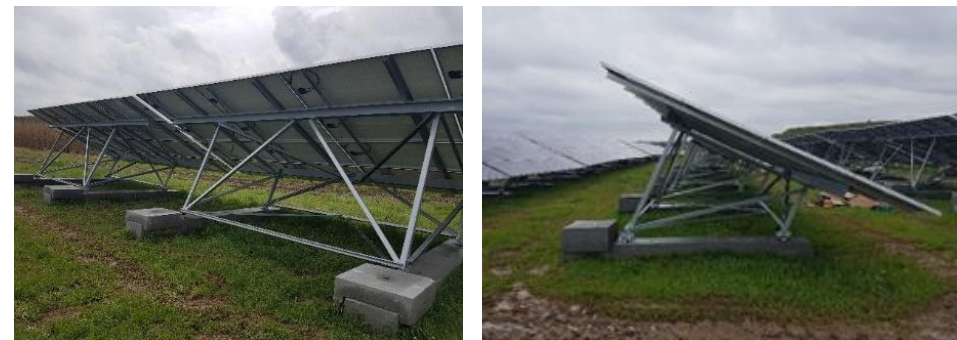
Exemple de fondations béton – Q ENERGY France
