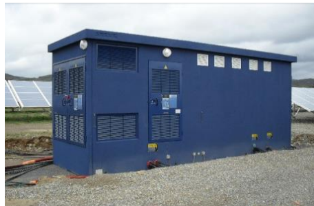
Exemples d'onduleurs et transformateur installés dans postes béton et containers
